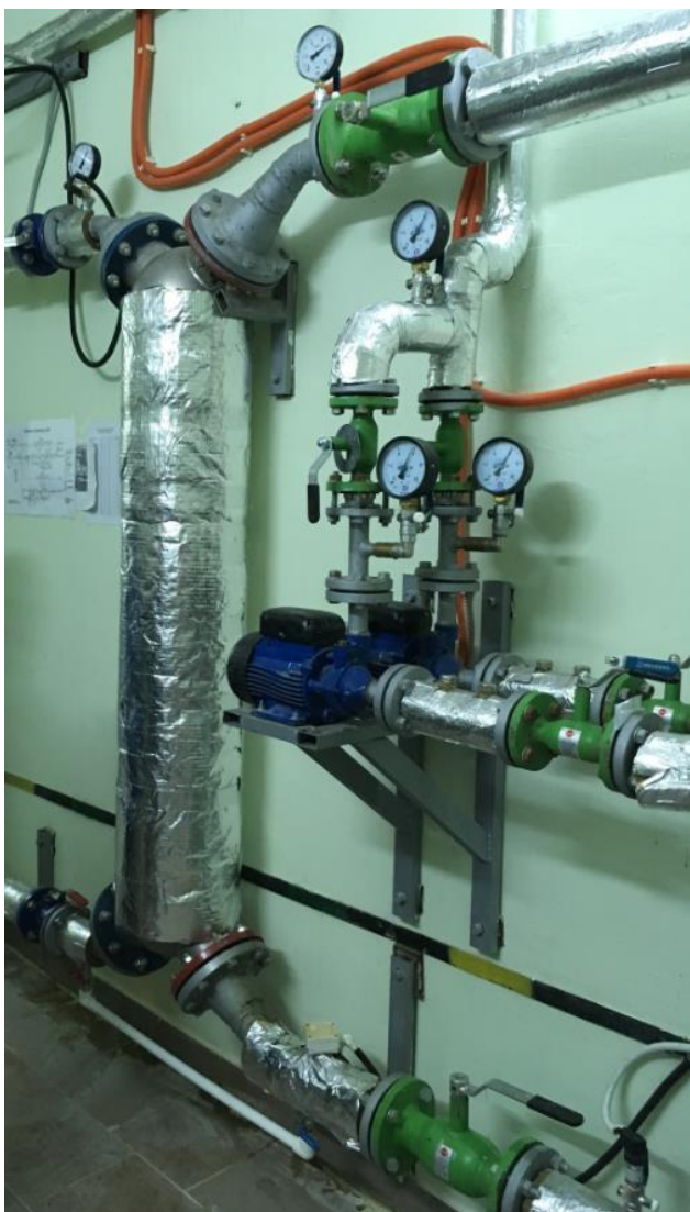
Рис. 2.7. Элементы схемы ИТП на базе кожухотрубных теплообменных аппаратов
