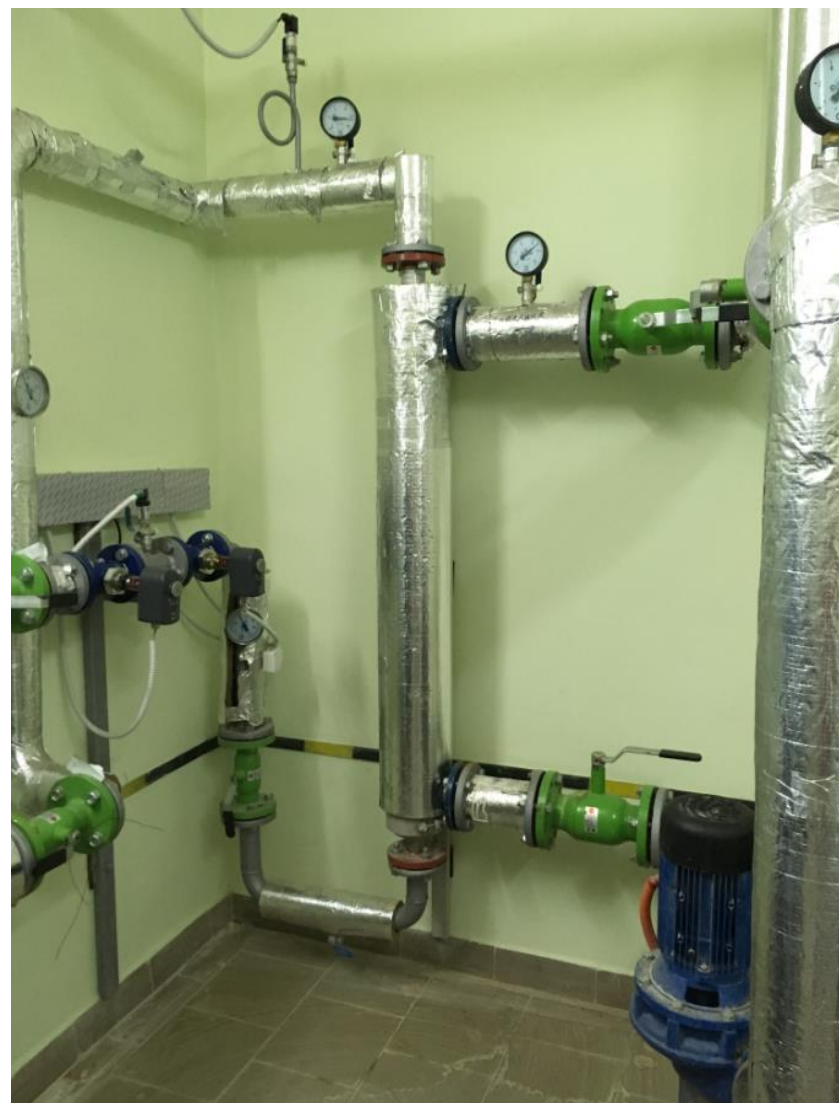
Рис. 2.7. Элементы схемы ИТП на базе кожухотрубных теплообменных аппаратов
